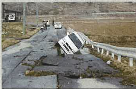
（左）青田地内市道殆森線。道路が陥没し車が落ちている
