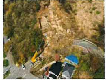
斜面が崩壊し道路が完全にふさがれた内郷内町の市道宮沢・堀内線(4月26日)
