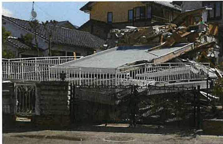
家屋の被災状況（南町地内）
