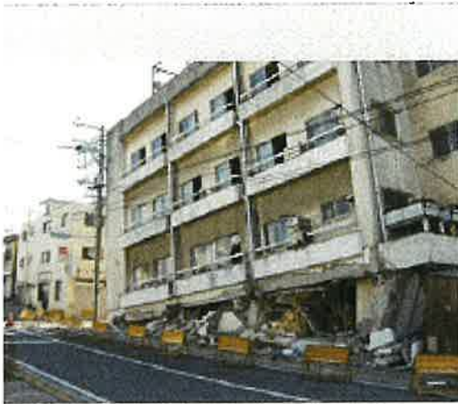
県道沿線の建物倒壊（郡山市陸山地区内）
