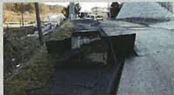
（左）青田地内市道殆森線。道路が陥没し車が落ちている
